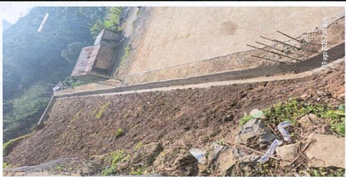
Foto 5: Finalización de construcción de cuneta
