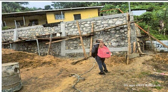
Foto 1: Avance de un 80% de la construcción del muro de contención
