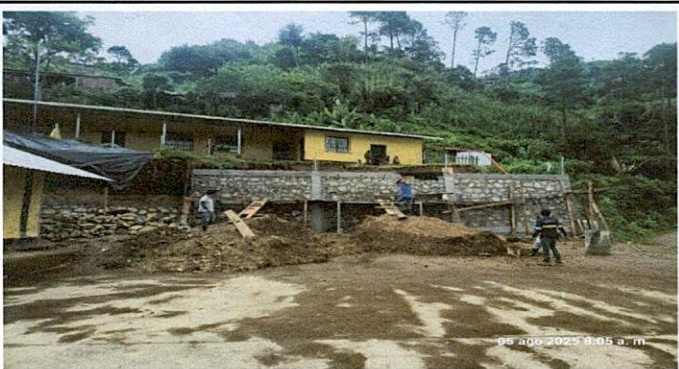
Foto 3: Retiro de tablas que sirvieron para el relleno de columnas
